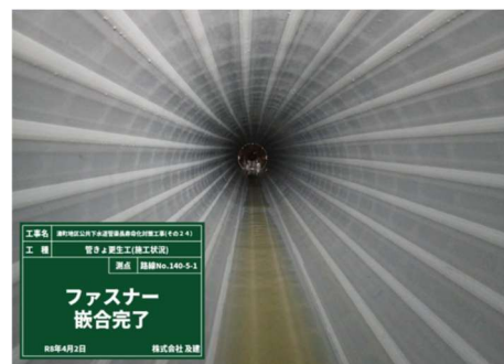
改築された下水道管
