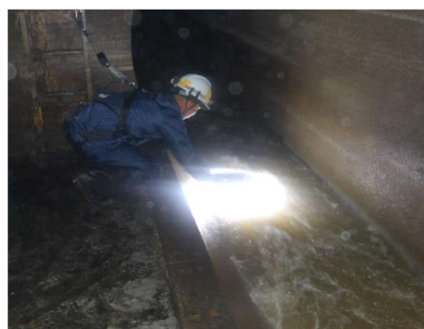
浮遊式カメラ調査状況
