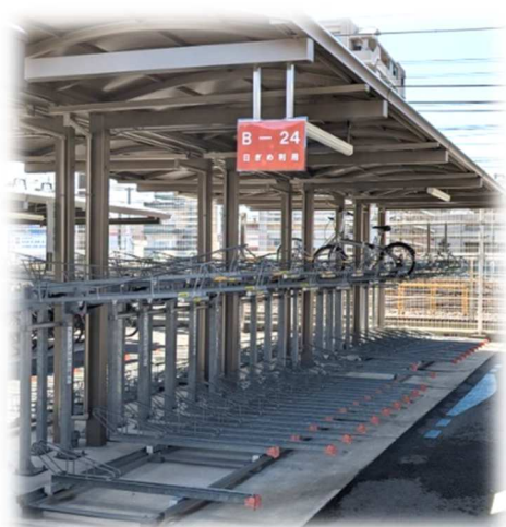
西船橋駅第 10 自転車等駐車場 (平成 31 年増設)
