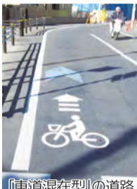
「車道混在型」の道路 と呼ばれる方法(上写真)で整備しています。
