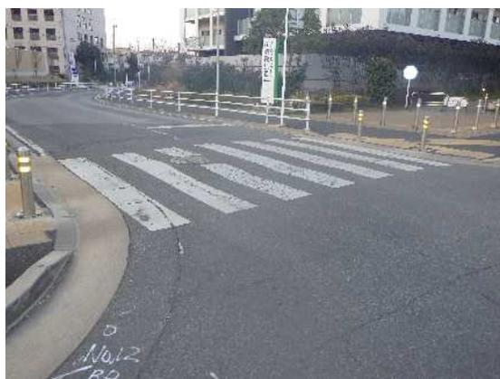
図 1-8 道路の舗装の劣化事例
